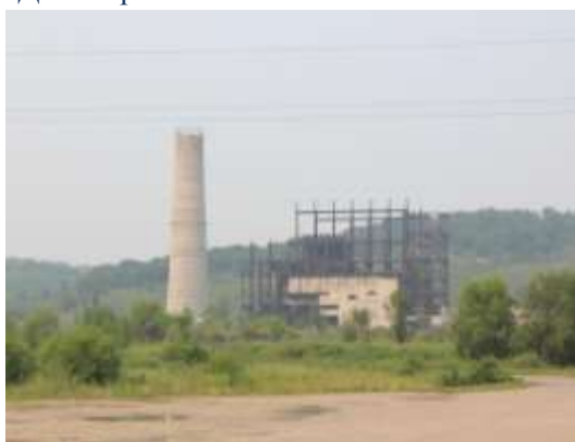
Приморский край, г. Уссурийск. ТЭЦ
