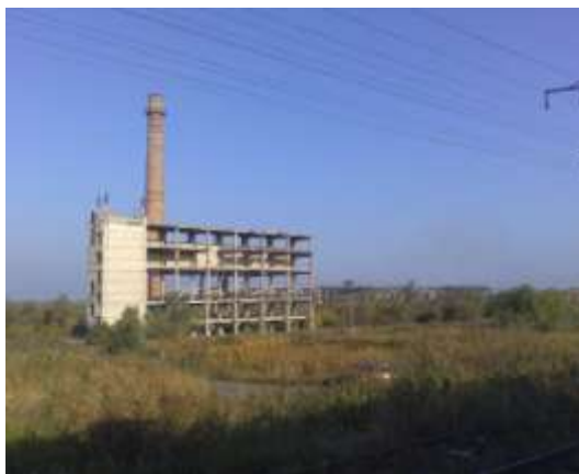
Приморский край, с. Михайловка. Домостроительный комбинат. 2015 г.
