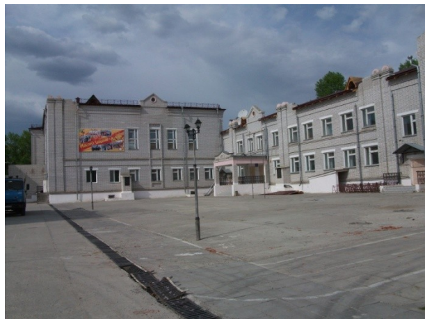
Фото 10. Строительство комплекса детский сад – школа
