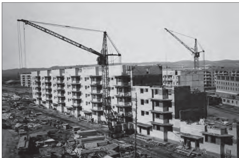
Строительство крупнопанельных домов в Хабаровском крае. 1981 г.
