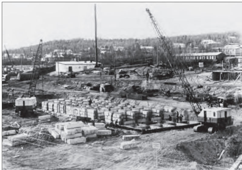
Закладка фундамента крупнопанельного дома. Амурская область. 1975 г.
