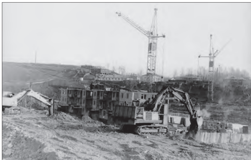
Возведение первого дома Находкинским МЖК.
