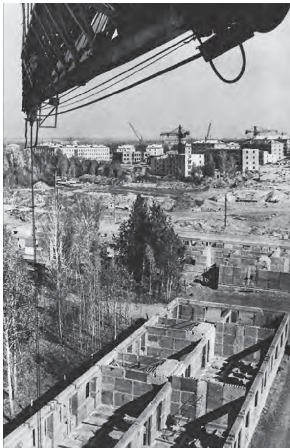
Строительство крупноблочного дома. 1960-е гг.
