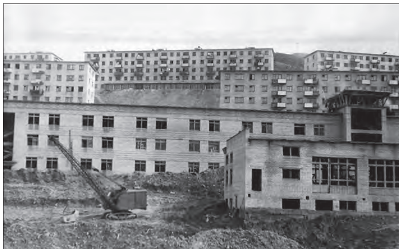
Строительство нового жилого микрорайона во Владивостоке. 1960-е гг.
