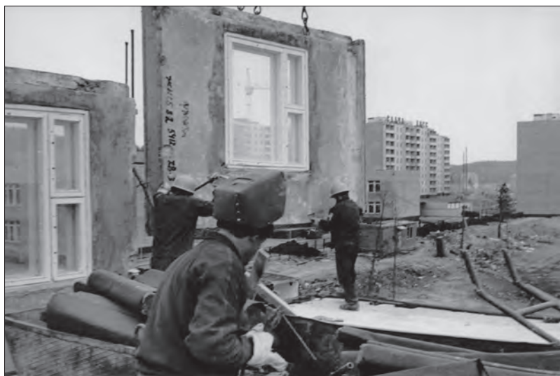
Строительство крупнопанельного дома в Амурской области.
