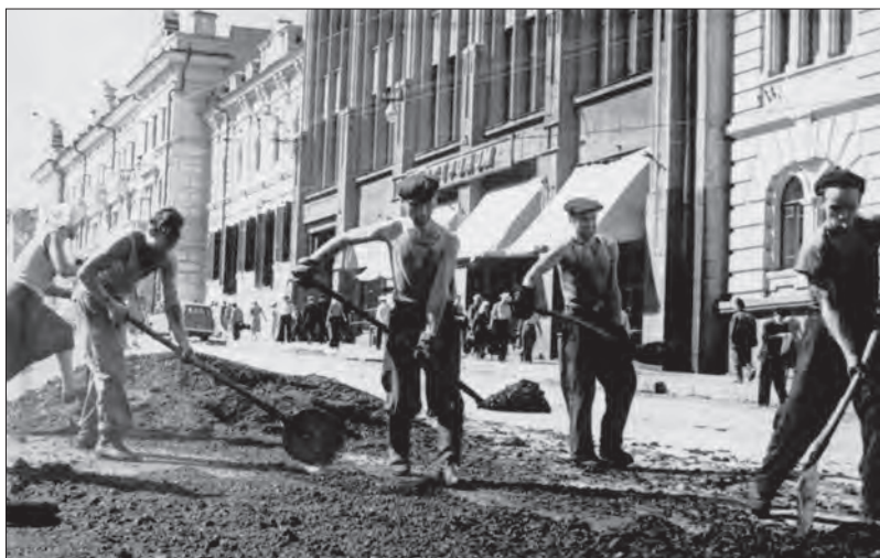
Укладка асфальта на Ленинской
