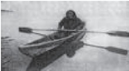
**ЧИСУ**, изготовленная из тополя остроконечная долбленая лодка айнов о-ва Сахалин. Для плавания по рекам и мелководным озёрам использовался шест.
